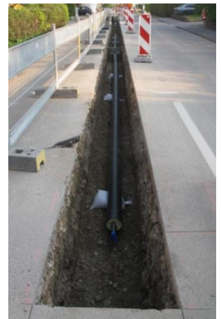
Verlegen Wärmenetz
