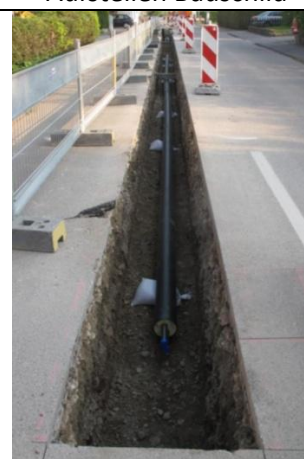
Die ersten Grabenmeter
